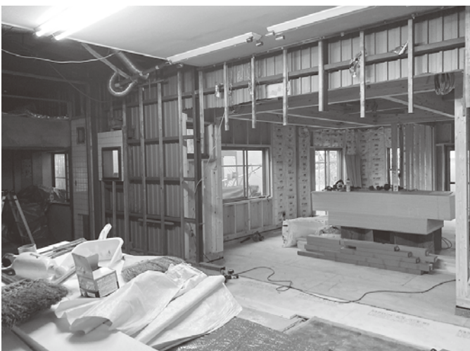
○ 工事中の様子 ○
