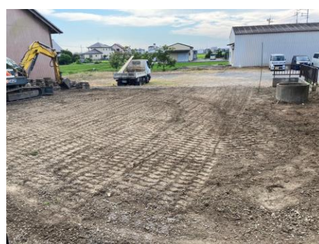
ワークショップとて・増改築工事
